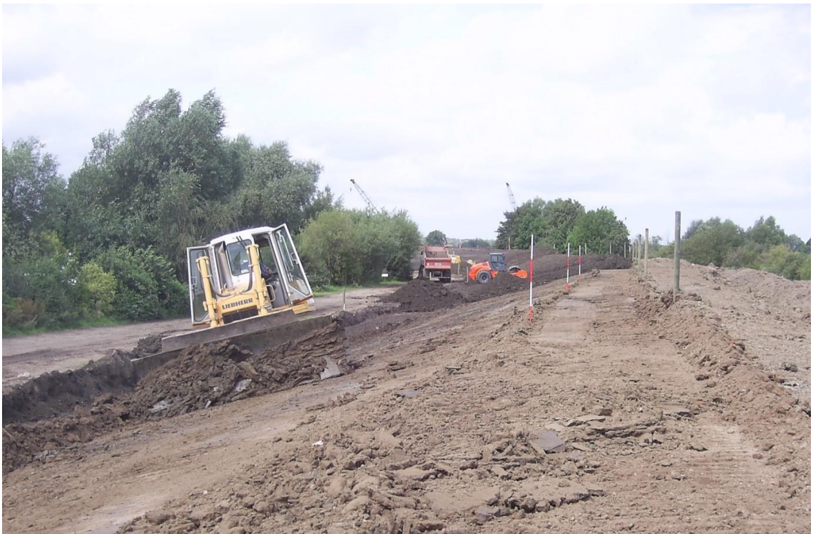
Deichbau in Rekum
